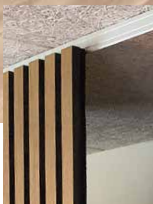
Privat hem Akustikpanel Oiled oak monterat på ett skensystem.
