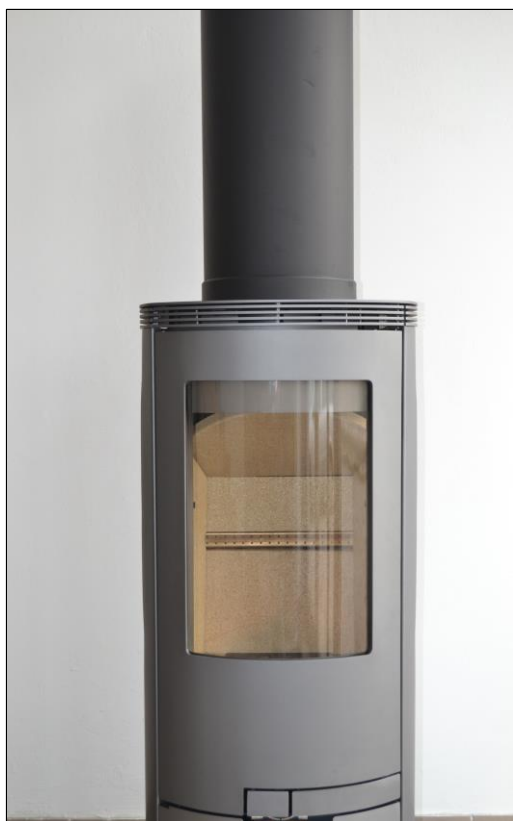
Elipse toppansluten och färdinstallerad för besiktning av skorstensfejaremästaren
