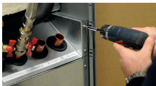
3. Avlägsna kylmodulens fästsruvar.
