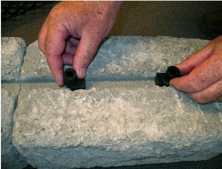
Bild 2. Montering av Bender Låsplugg för vertikal mur. Montera två st. Bender Låsplugg per block.
