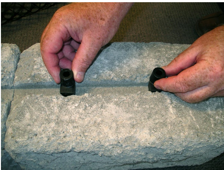
Bild 3. Montering av Bender Låsplugg för lutande mur. Montera två st. Bender Låsplugg per block.
