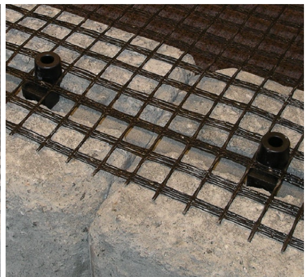
Bild 3. Montering av Bender Geonät på första skiftet. Sätt fast nätet över låspluggarna. Låt pluggarna sticka upp ur tredje raden på nätet så att så mycket nät som möjligt ligger mellan stenlagren utan att sticka ut. Då sitter nätet bäst.
