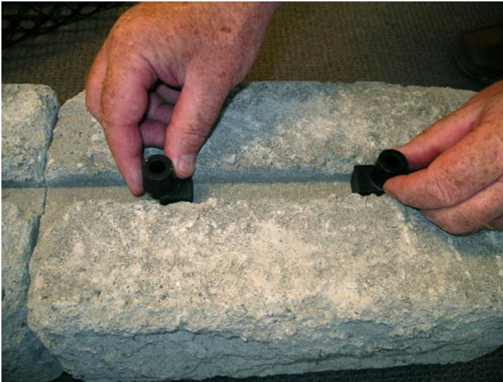
Bild 2. Montering av Bender Låsplugg för vertikal mur. Montera två st. Bender Låsplugg per block.
