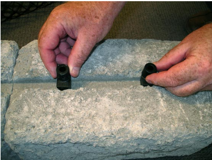
Bild 3. Montering av Bender Låsplugg för lutande mur. Montera två st. Bender Låsplugg per block.
