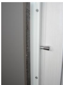
Låssprint i öppet läge
