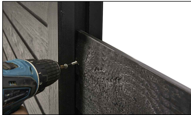
Fastgørelse af brædder, skrue i hver side.
