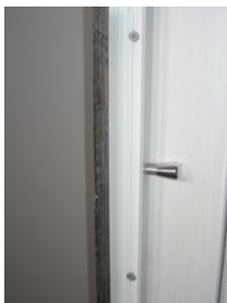
Låssprint i öppet läge
