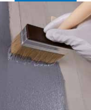
Applicering av Eco Prim Grip på betong med borste
