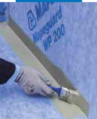
Applicering av Mapeguard WP Adhesive för tätning av alla fogar i hörnet innan Mapeguard S appliceras
