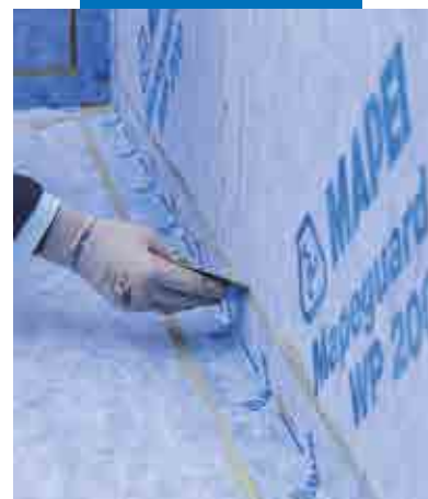
Applicering av Mapeguard ST
