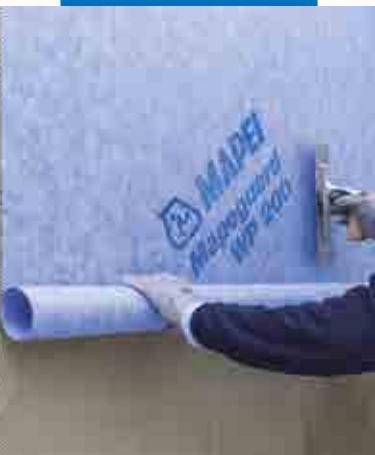
Läggning Mapeguard WP 90
