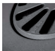
Skakroster i gjutjärn underlättar rengöring
