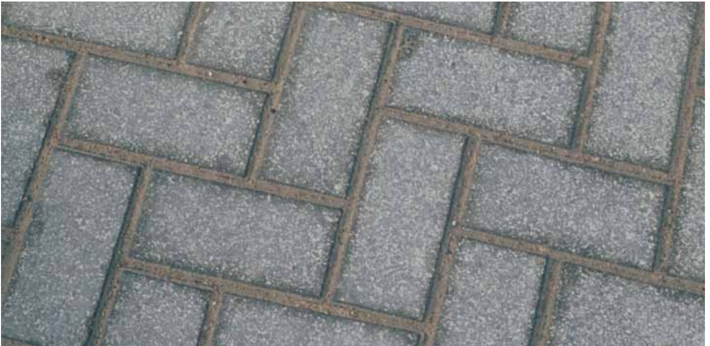
En välfylld fog hindrar ogräs och ger en stabil beläggning som tål påfrestningar.
