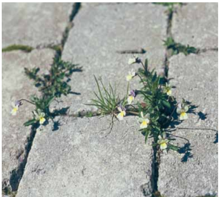
Halvfyllda fogar eller för grovt fogmaterial i kombination med lågt slitage ger ogräset en chans att etablera sig.
